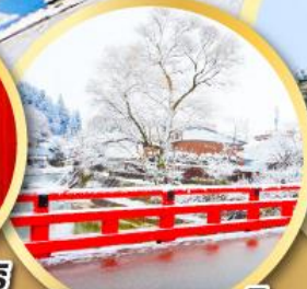
สะพานนากะบาชิ
